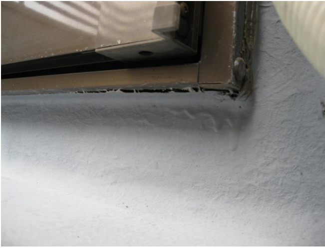
FRPの前にサッシを取り付けたせいで隙間が！
