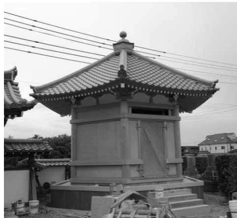
完成間近の六角納骨堂（八月撮影）
