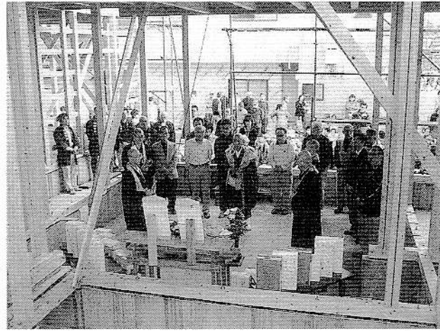
長泉寺様の上棟式の様子(平成23年5月)
