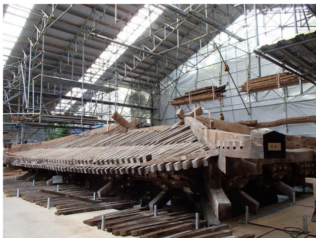
小屋組が外され軒回り解体中
