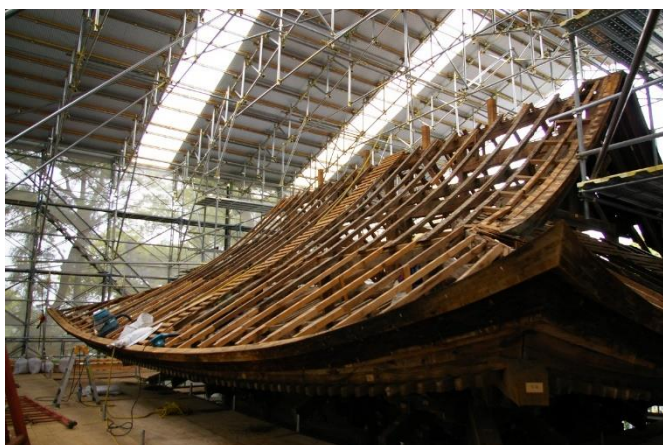
屋根葺材と野地板を解体した様子
