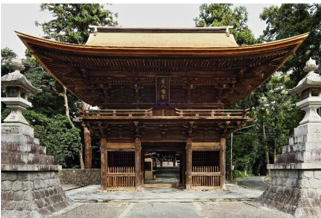
完成した楼門
