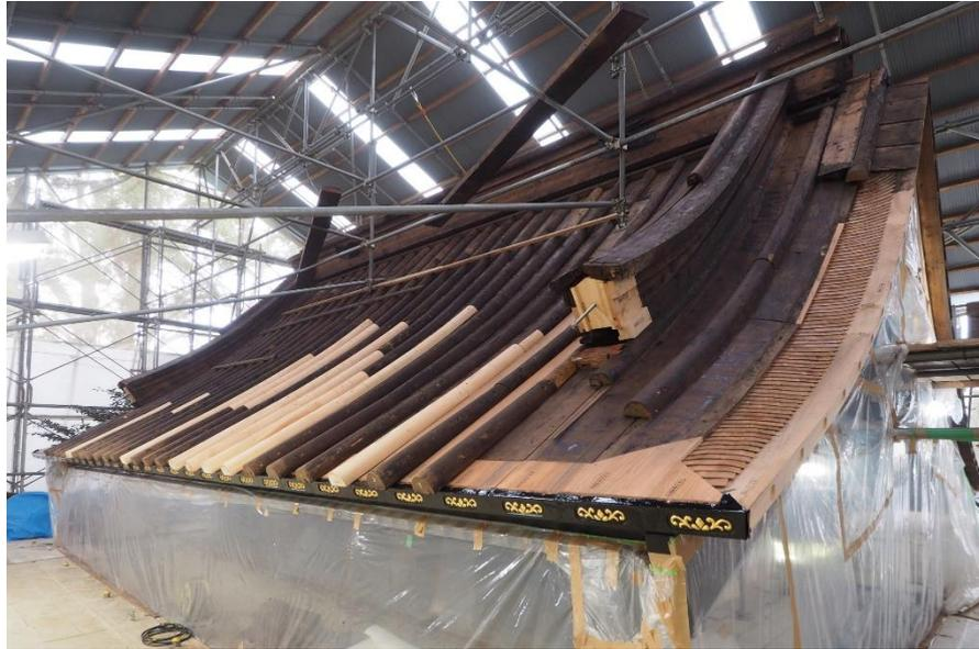
屋根の下地の傷んでいる部分だけ取替えをし、銅板葺きの工事をします。
