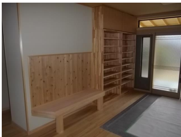
段差のない玄関
