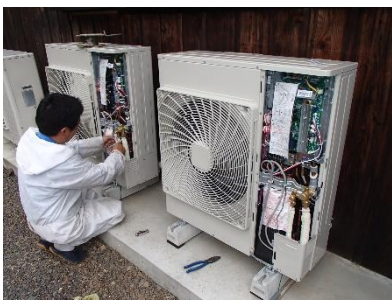
室外機取付の様子
