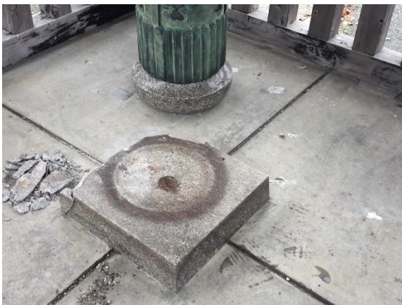
沓石から 60 cmほどのところに、礎盤 と柱がとんだ様子
