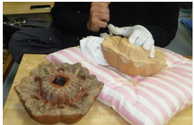
損傷の激しい部材を同種材にて、忠実に再現して彫刻していきます。
