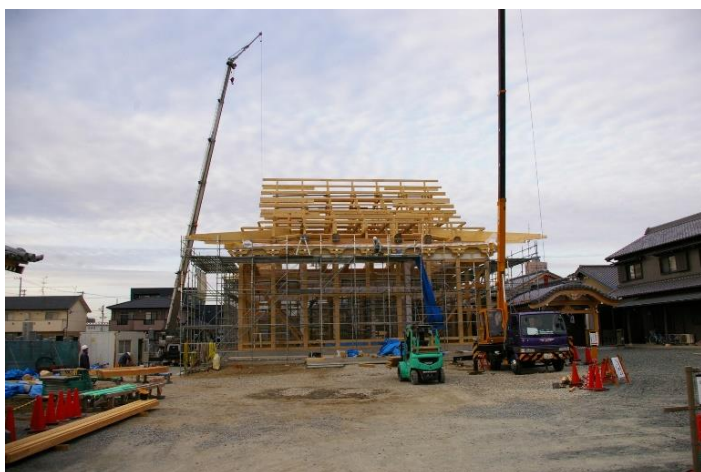
上棟の工事中
