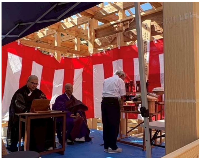
浜松市浜名区 西光院様 本堂位牌堂書院新築 上棟式
