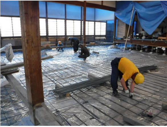
基礎工事の様子。床を解体し防湿シート敷きの上に鉄筋を組立て中
