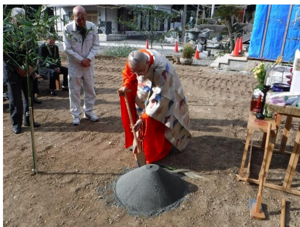
平成 25 年の本堂屋根替え・耐震補強工事に 続きご用命いただき感謝しております。
