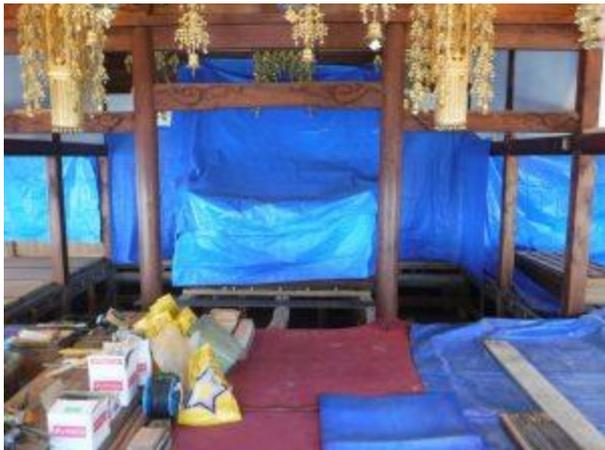
そして浜松市東区小池町にある長泉寺様(臨済宗方広寺派)では位牌堂の改修工事が二月から始まりました。主な工事は瓦の葺き替えと畳の床を補強しながらフローリングに張り替えです。大引を三尺(九〇cm)ピッチに入れ、根太間も一尺(三〇cm)ピッチに入替え補強をしました。そしてこれから屋根葺き替え工事を、春のお彼岸までに完成の予定で工事を進めてまいります。
