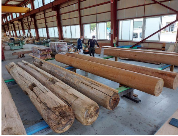
手前側の傷んだ丸柱を、埋め木・剥ぎ木等で補修し再使用します。
