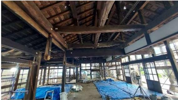
移築再利用のため大工の手により丁寧に解体しています。
