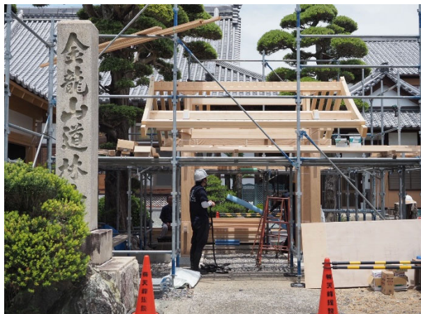
刻み材を組み上げ 上棟へ
