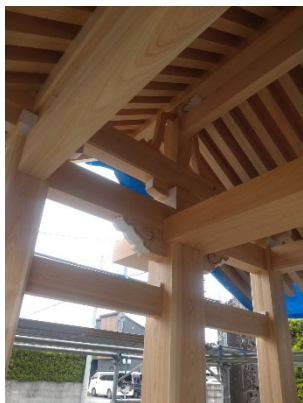
刻み材を組み上げ 上棟へ
